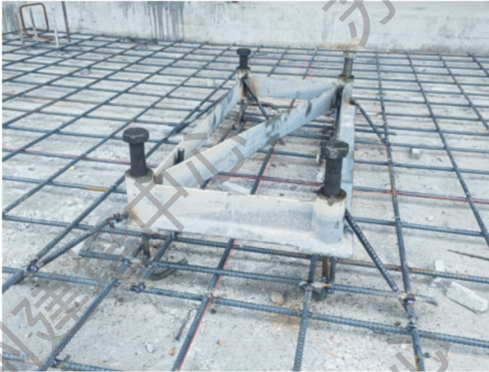
图 3.4-1.1 预埋基础底架图
