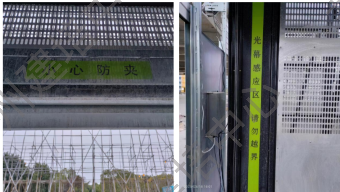
图 2.3 吊笼门安全保护系统
