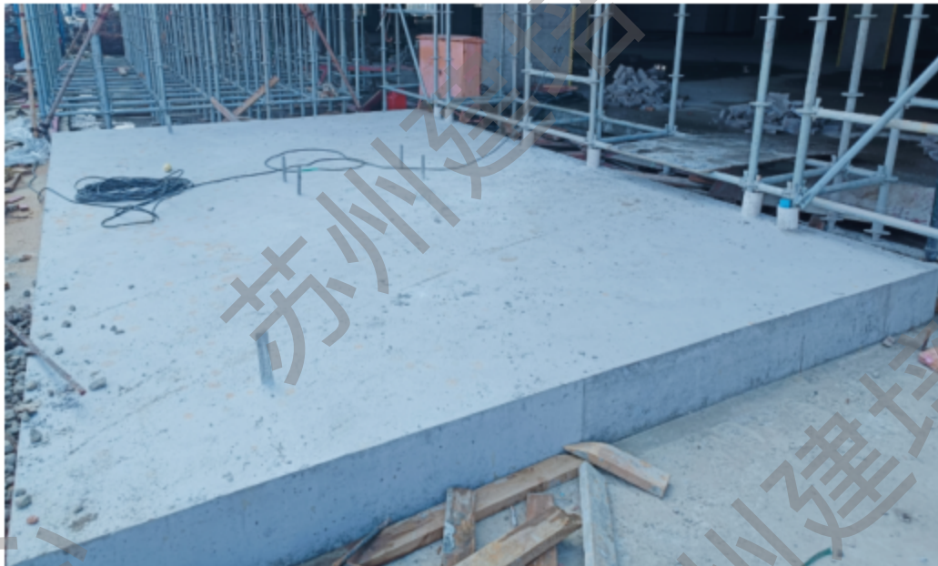
图 3.4-1.2 基础浇筑
