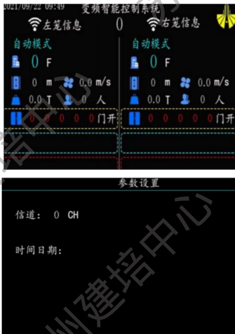
图 3.4.6.2-6 底层操作站显示屏
