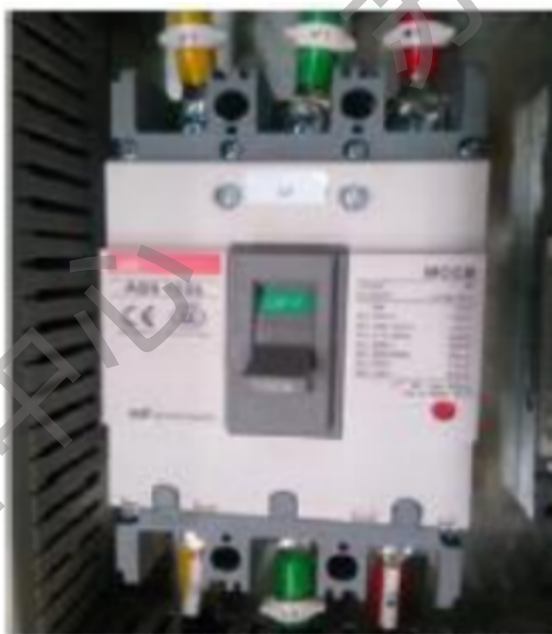
图 3.4.6.2-1 下电箱短路器（分断状态）
